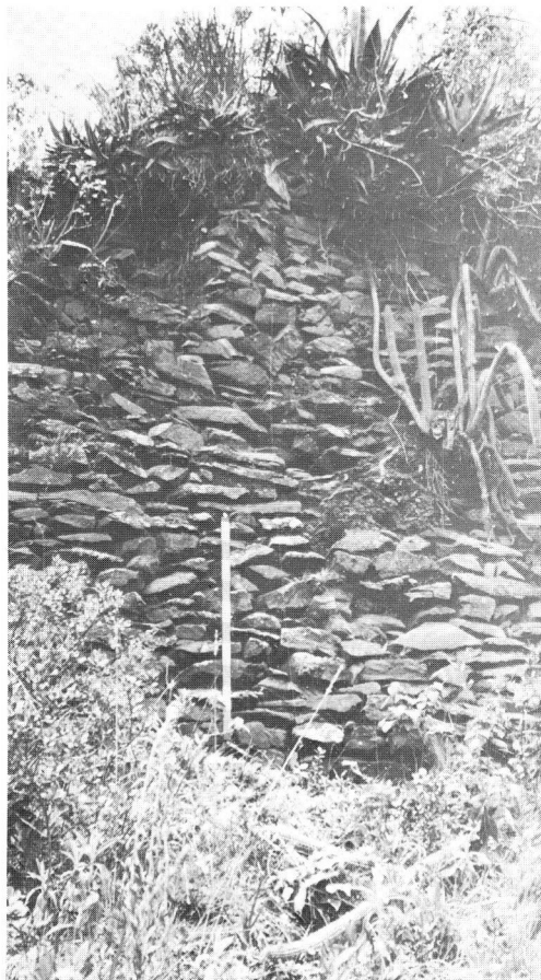
Fig. 7 - Cerro Llaver. Trozo de muralla hacia el E. con mortero de barro arcilloso. Chordeleg.
