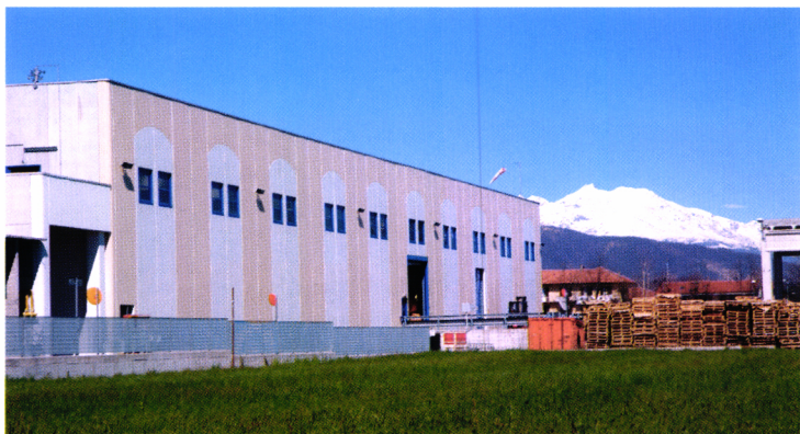
Veduta esterna della cartiera.
